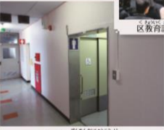
トイレ全面改修工事
