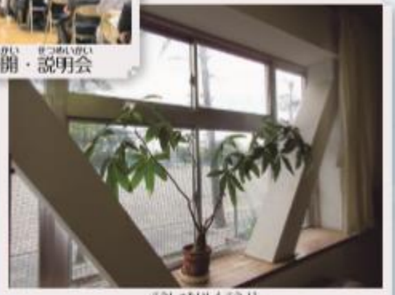
校舎耐震工事
