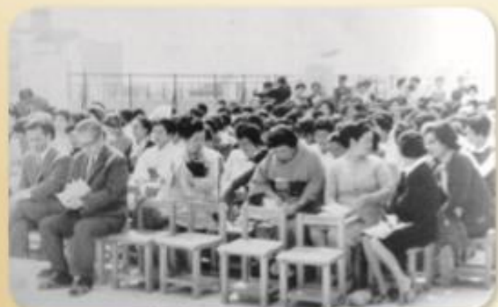
屋上でのPTA総会
