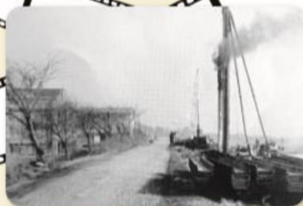
旧江戸川堤防改修工事
