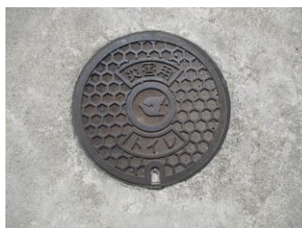
「マンホールトイレ」
