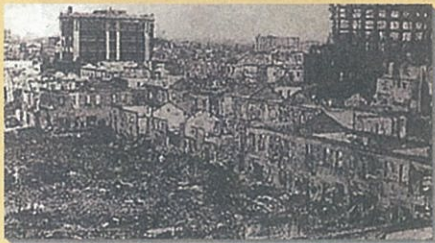
大正12年(1923年) 関東地震(関東大震災)M7.9 地震とその後の火災の被害が大きかった。 死者行方不明者約105,000人、 こわれたり焼けたりした建物約423,000戸。
