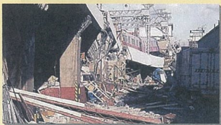
平成7年(1995年) 兵庫県南部地震(阪神・淡路大震災)M7.3 地震とその後の火災の被害が大きかった。 こわれた建物の下じきになって、多くの人がなくなった。死者行方不明者6,437人、 こわれた家屋249,180戸。
