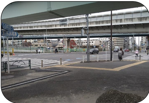
★清砂大橋交差点（通学路で交通量が多い）
