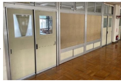
④後方出入口を設置し完成
