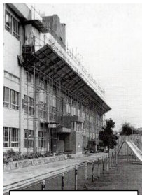
4階部分を つけたす工事
