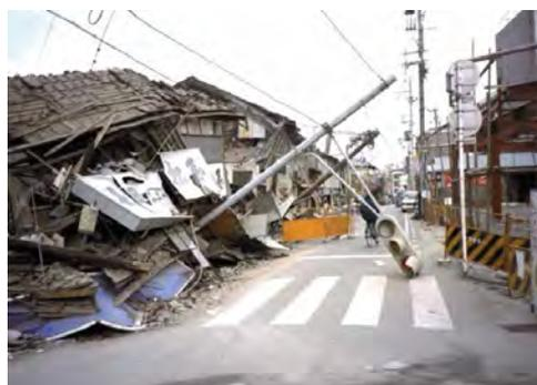
写真1 阪神・淡路大震災で倒壊した電柱
